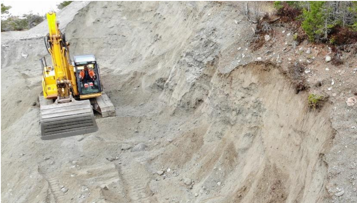
Figur 1. Med gravemaskin blir arbeidet effektivt. Den gjør det også enklere å få til tilstrekkelig høyde på fasaden.
